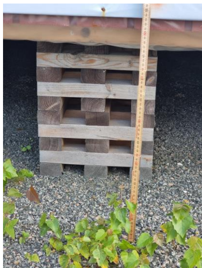
Figur 4:27 Klossar och pallar med olika höjd som skapar en nivåskillnad för att underlätta avrinning och minimera vattensamling på emballerade modulers tak. Klossar och pallar ska hållas innanför modulen enligt foto till vänster och inte såsom lastpallarna är placerade i foto till höger (Foto: Hanna Bülund).
