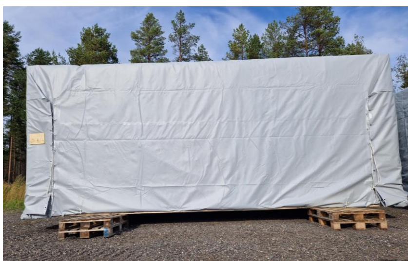
Figur 3:9 Exempel på extra skydd med kapell av tungpresenning utanpå emballerad modul. Extra skydd av tungpresenning ger också bättre förutsättningar för snöröjning på toppen av volymer (Foto: Borne Gebing).
