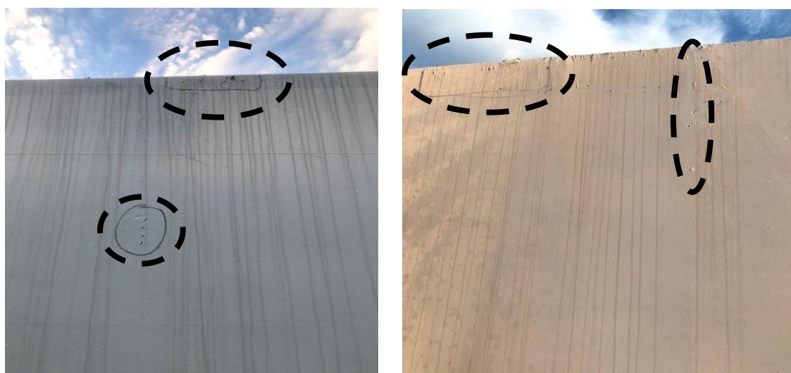
Figur 4:5 Fuktkvotsmätningar efter 12 veckor på testvolymen D och L. D: 25,2% respektive 16,7%. L: 23,1% respektive 16,1% (Foto: Mats Larsson).
