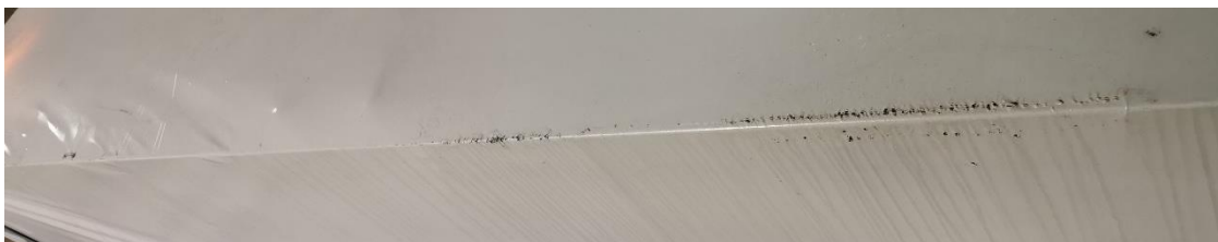
Figur 4:6 Exempel på skrapmärken efter spännband längs långsidornas överkant ena sidan av modul (Foto: Göran Berggren).
