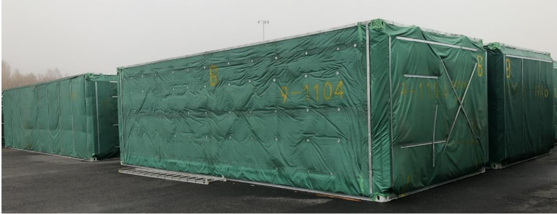
Figur 3:10 Moduler på lastbärare för transport till andra sidan jorden med båt (Foto: Lars Oscarsson).
