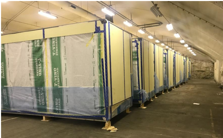
Figur 4:1 Mellanlagring av prefabricerade moduler i bergum (Foto: Lindbäcks Bygg).
