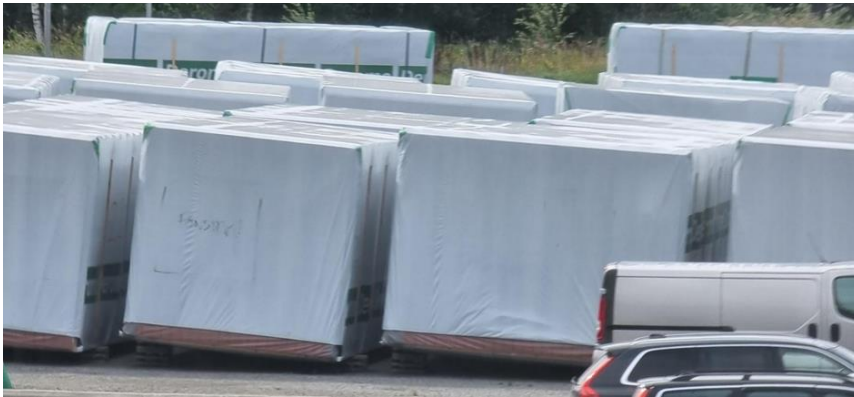
Figur 4:14 Moduler lutas för att underlätta avrinning och minimera vattensamlingar på dess emballerade tak (Foto: Hanna Bülund).
