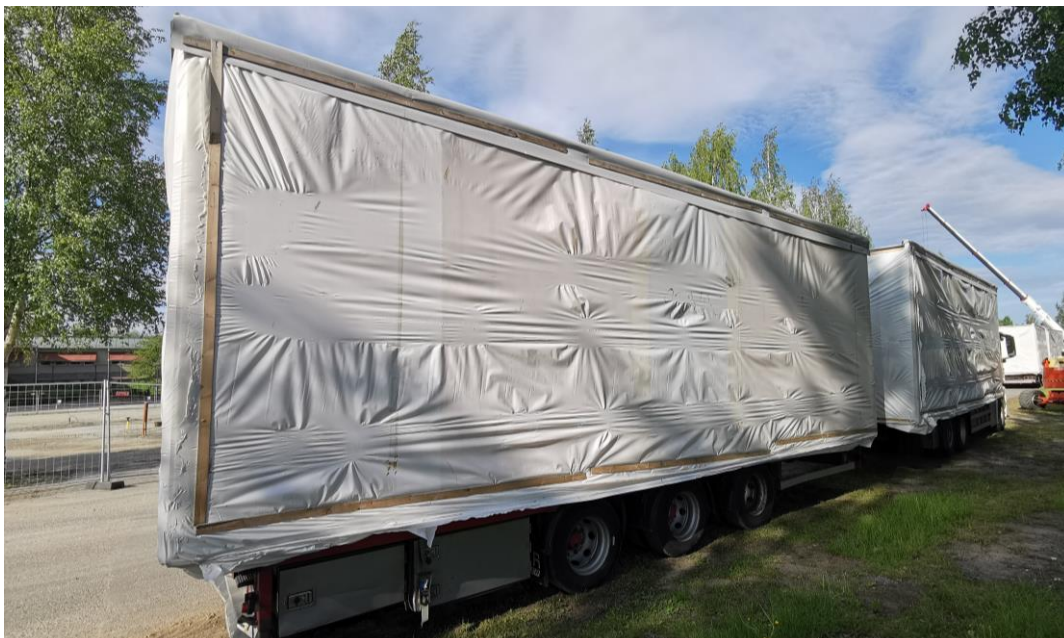
Figur 3:7 Moduler med emballage av krympplast som även kompletterats med liggande och stående läkt/ribbor. Notera det förstärkta skyddet på taket, "hättan" i form av en PVC-presenning som har fästs in med liggande läkt/ribbor (Foto: Göran Berggren).
