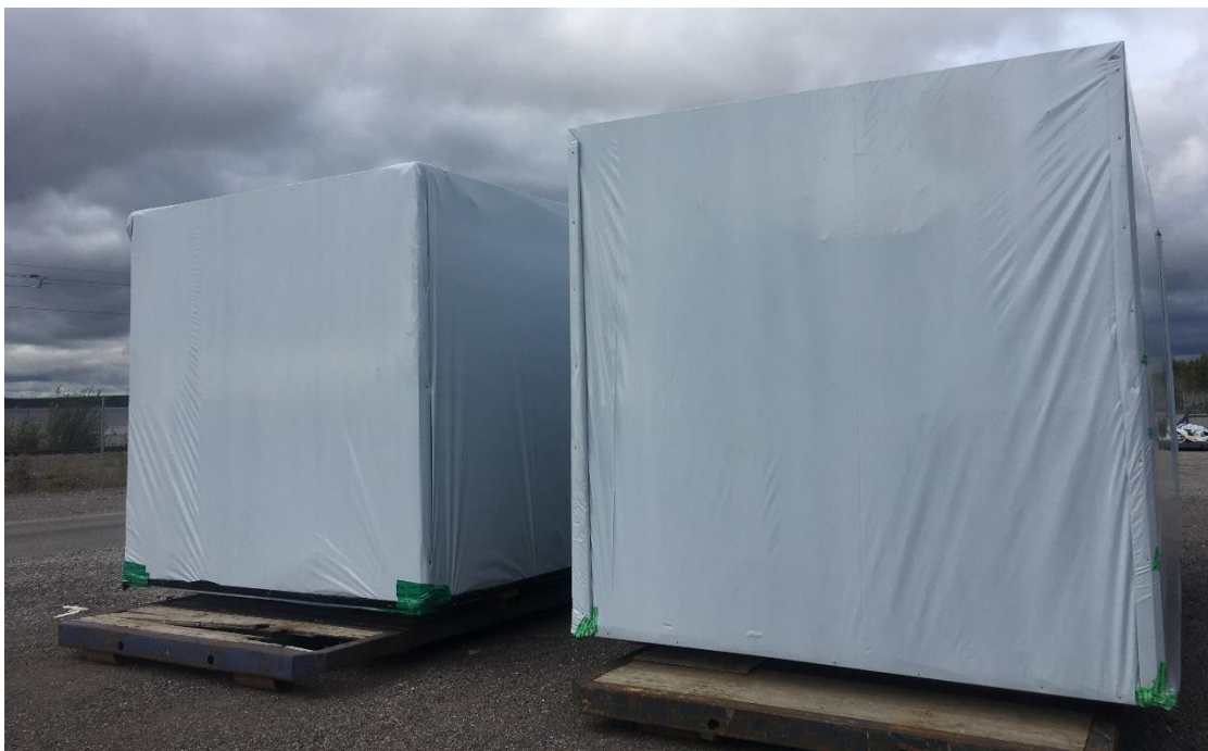
Figur 4:18 Emballerade volymer där emballaget sträckts upp och fästs in med läkt/ribbor på två olika sätt i nederkant. För den vänstra modulen har emballaget spänts genom att läkten rullats "utåt". För den högra modulen har emballagets istället spänts genom att läkten rullats "inåt" (Foto: Göran Berggren).
