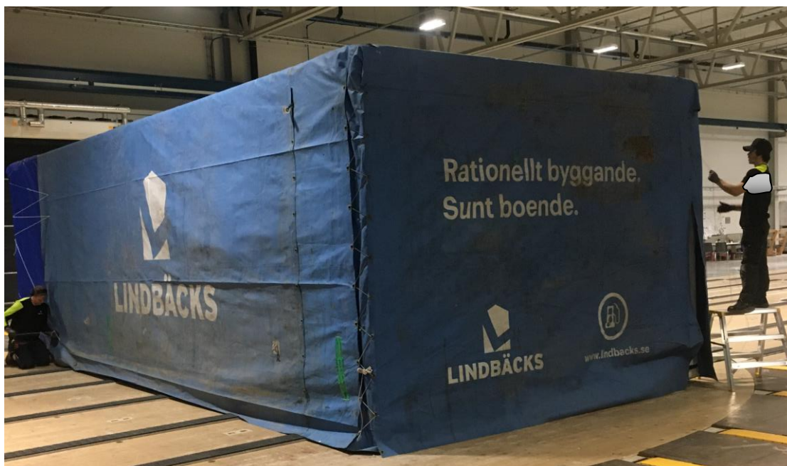
Figur 4:23. Extra skydd med kapell av tungpresenning utanpå emballerad modul. Extra skydd av tungpresenning ger också bättre förutsättningar för snöröjning på toppen av volymer (Foto: Lars Oscarsson).
