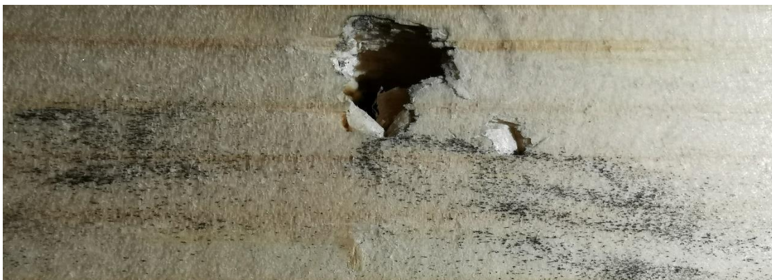
Figur 4:29 Fläckar med svartmögel som begränsas till en liten del av en regel (Foto: Göran Berggren).
