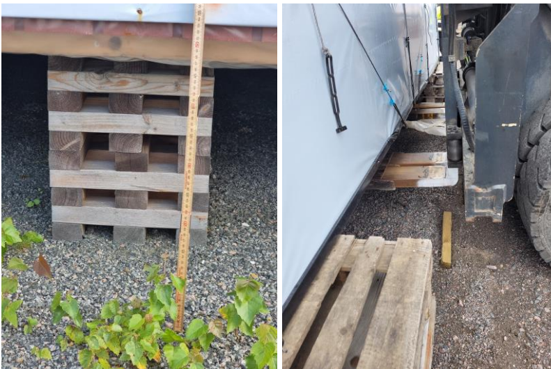
Figur 4:15 Klossar och pallar med olika höjd som skapar en nivåskillnad för att underlätta avrinning och minimera vattensamling på emballerade modulers tak (Foto: Hanna Bülund).
