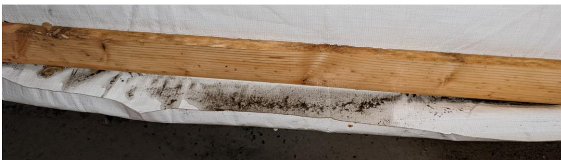
Figur 4:21 Exempel på vattendike som skapats bakom vikning/sträckning av folie (Foto: Göran Berggren).
