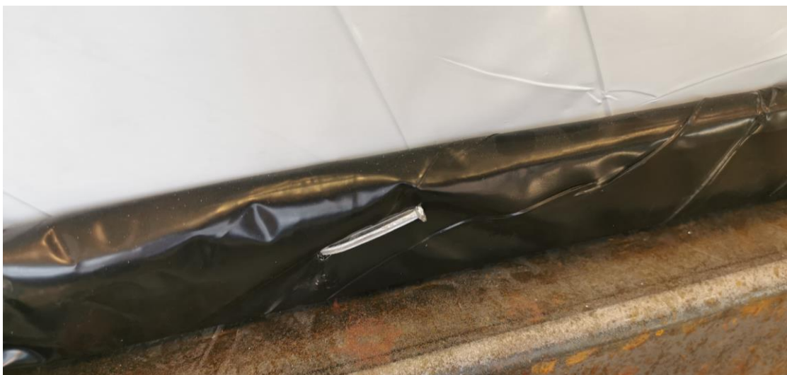
Figur 4:20 Emballering med liggande/ horisontell läkt i nederkant skapar lätt ett vattendike med hål från infästningsspiken in mot volym (Foto: Lars Oscarsson).
