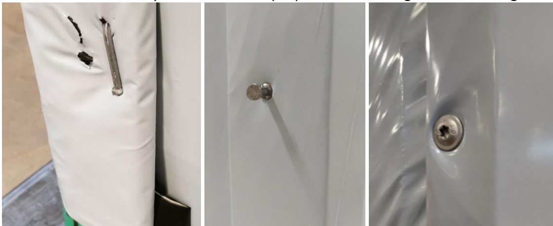
Figur 3:3 Exempel på olika typer av vikningar runt hörn och olika typer av fästelement (Foto: Göran Berggren)
