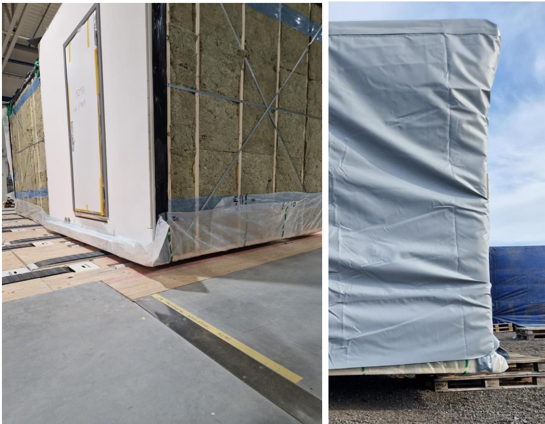
Figur 3:2 Exempel på hur en modul kan emballeras sexsidigt med extra förstärkning av tungpresenning. A Transparent bottenemballage så att inträngande fukt/vatten kan observeras och undertill. B Bottenemballage samt emballage på sidan, den extra förstärkningen av tungpresenning har medvetet dragits upp för att visuellt åskådliggöra botten emballagets uppvik och att bakomliggande sidoemballage ligger på utsidan av bottenemballaget (Foto: Borne Gebing).
