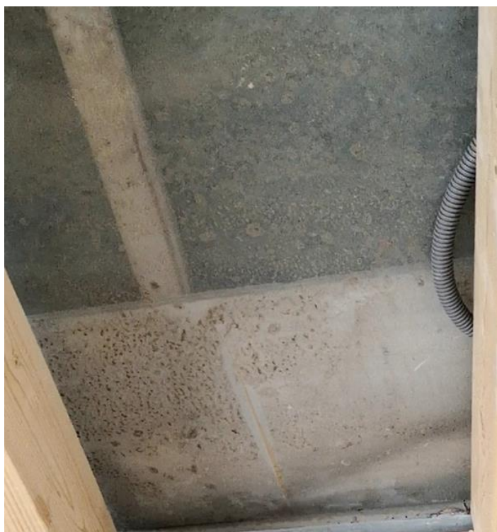
Figur 4:24 Exempel på undersida modul som fuktats upp och smutsats ner under transport p.g.a. avsaknad av bottenemballering vid transport (S. Olof Mundt-Petersen).
